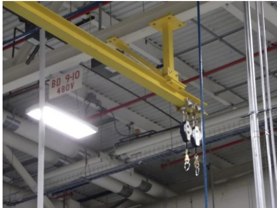
ภาพที่ 3-2 โครงสร้างที่มั่นคงแข็งแรงเหนือศีรษะบริเวณพื้นที่ปฏิบัติงาน
