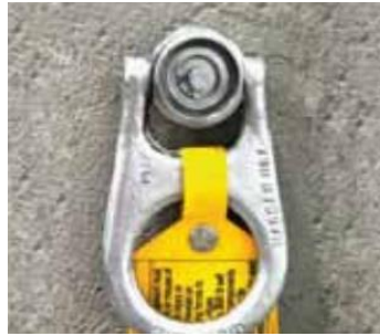
ภาพที่ 2-3 ตัวอย่างจุดยึดเกี่ยวชนิดแคสอิน
